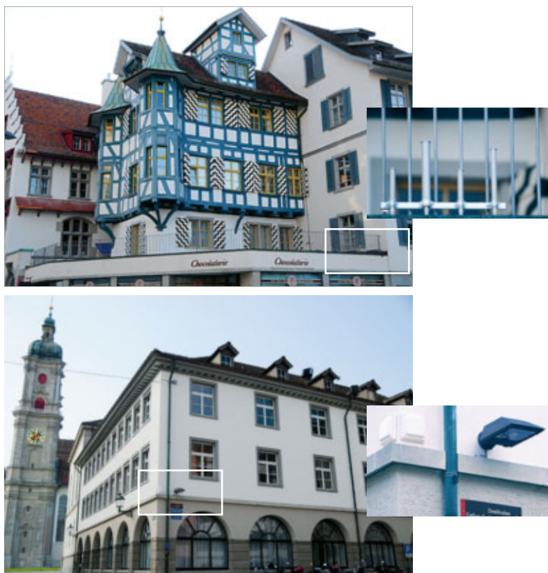
Des antennes WLAN peu visibles fournissent un accès à Internet sans fil avec un faible rayonnement dans une partie du centre de Saint-Gall: exemples de dispositifs montés sur un réverbère, une balustrade en métal et un coin de bâtiment.
