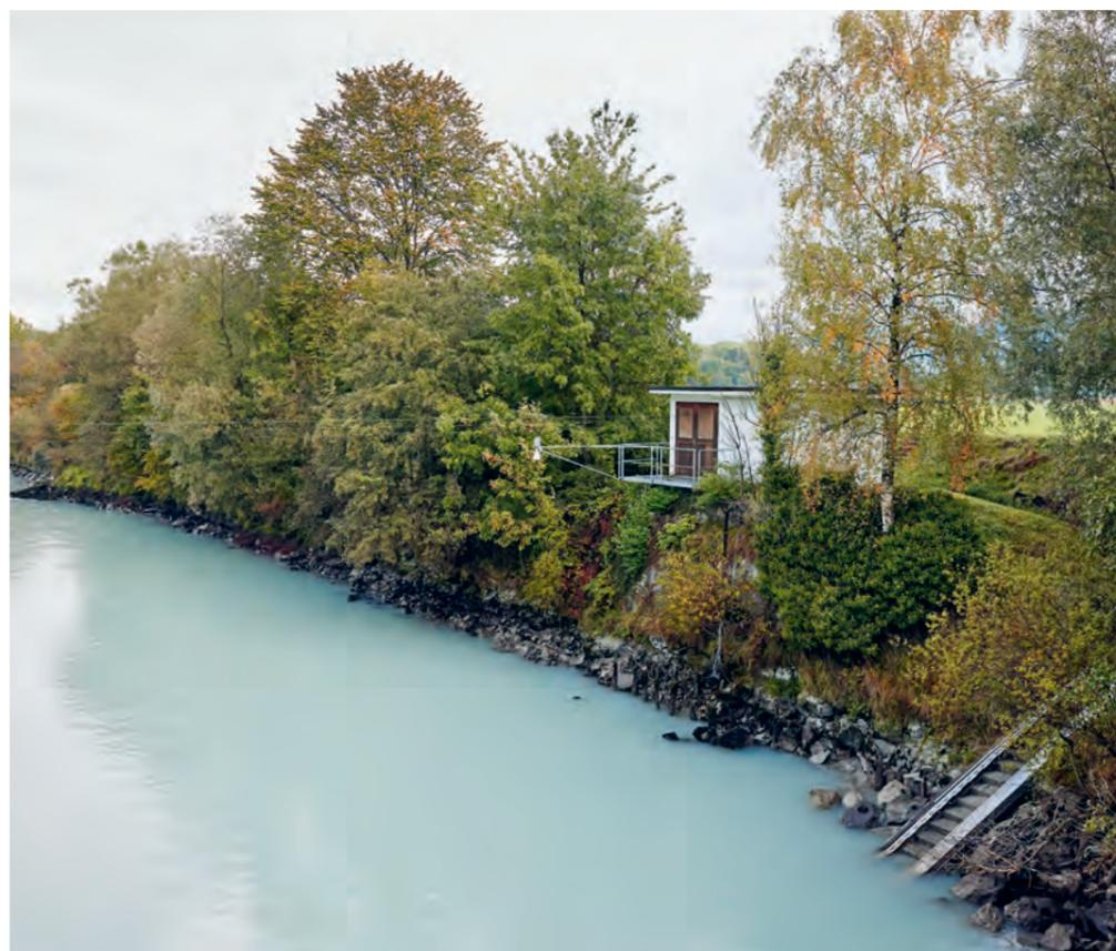
La station de la Porte-du-Scex, en amont de l'embouchure du Rhône dans le lac Léman : la rampe à droite mène à la pompe submersible et aux différents capteurs dans le fleuve.
